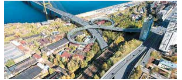
Строительство мостового перехода через реку Каму с устройством подходов для сопряжения с ул. Окулова на левом берегу и с ул. Борцов Революции на правом берегу
