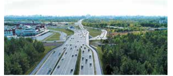
Строительство нового направления от ул. Борцов Революции до ул. Жукова и реконструкция транспортных узлов «Примыкание ул. Спешилова к проектируемому новому направлению» и «Пересечение ул. Докучаева и дороги Дружбы с ул. Спешилова и ул. Якутской»
