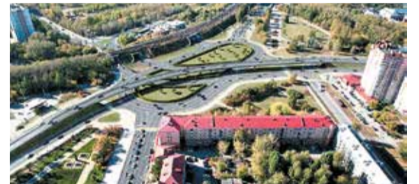
Строительство эстакады на транспортном узле «Площадь Гайдара» с реконструкцией подходов по ул. Екатерининской и ул. Окулова
