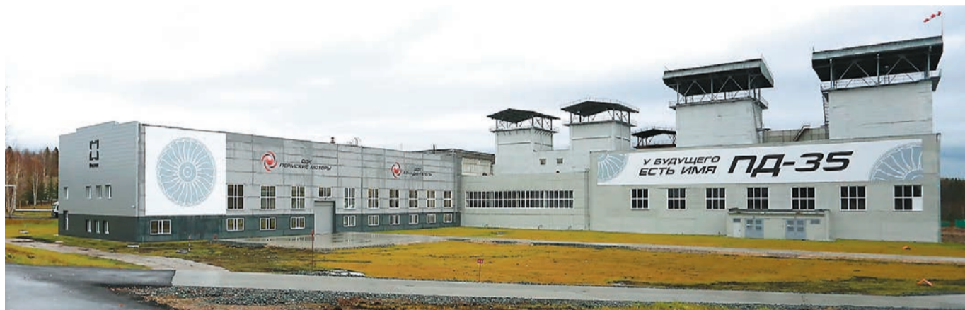
Загородная испытательная станция АО «ОДК-Пермские моторы» в Новых Лядах
