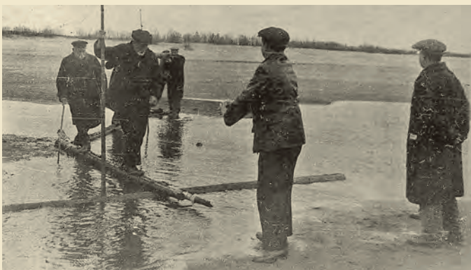
На дороге к нефтяной скважине, 1929 год
