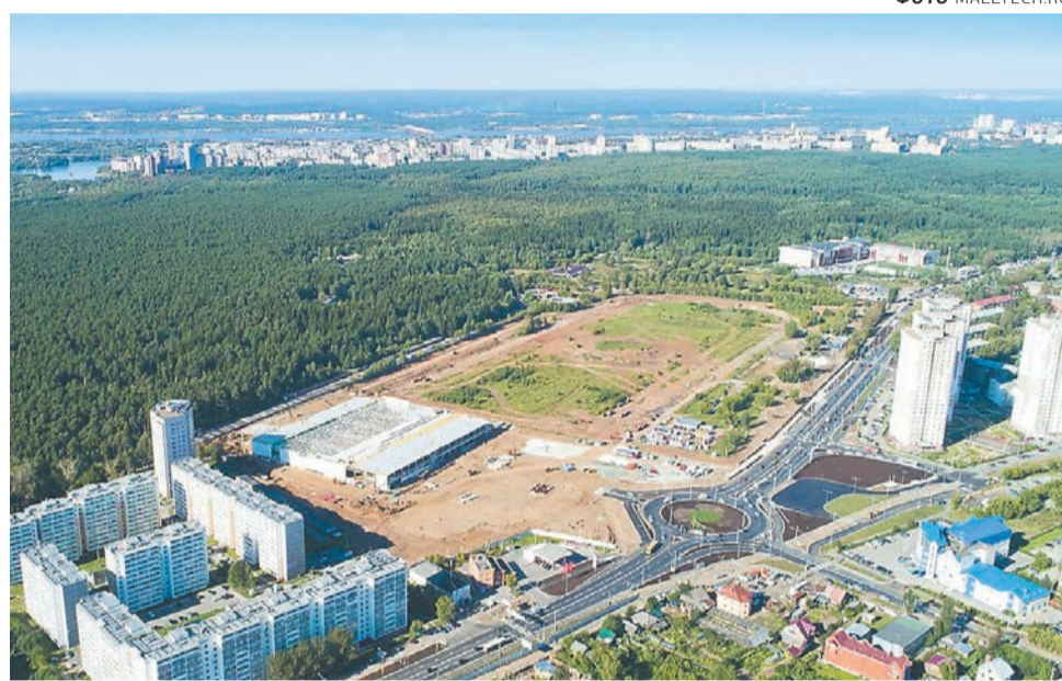
Строительство ТЦ «Планета» на месте Ипподрома уже началось
