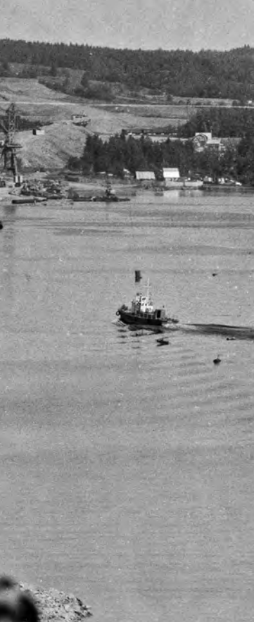
Общий вид строительства моста через реку Чусовую. 1990-е годы
