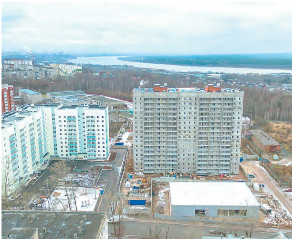
Ведётся строительство новых домов в микрорайоне Вышка-2
