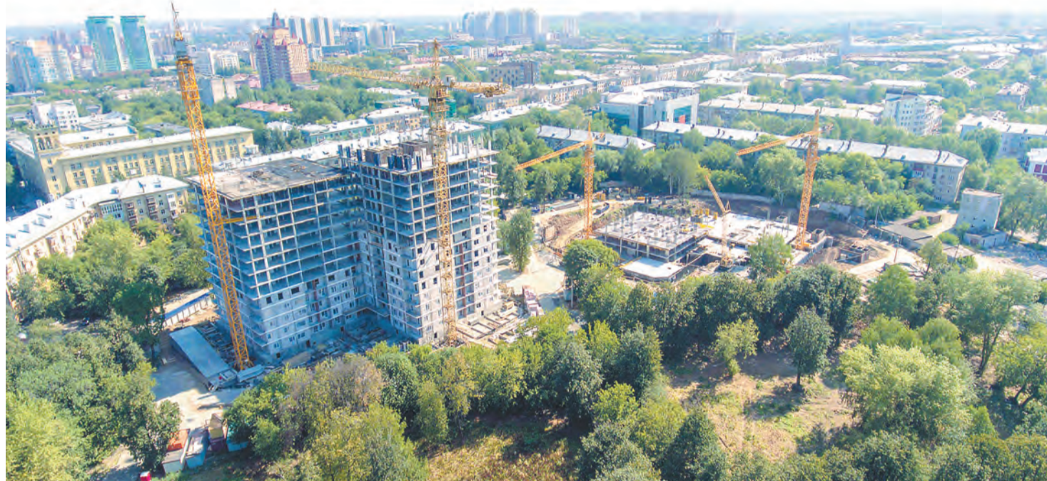
Вид на стройплощадку ЖК «Гулливвер» с высоты птичьего полёта
