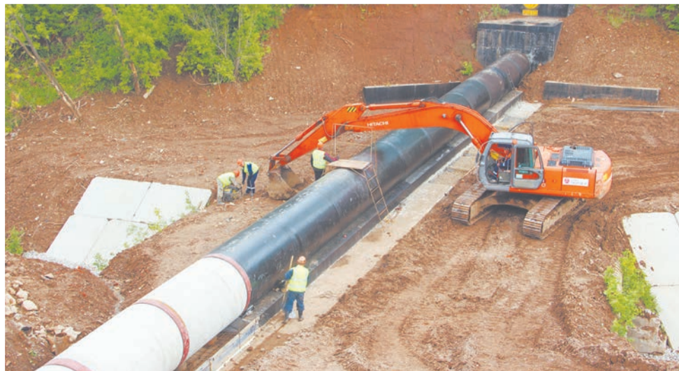
Идёт монтаж главного разгрузочного коллектора
