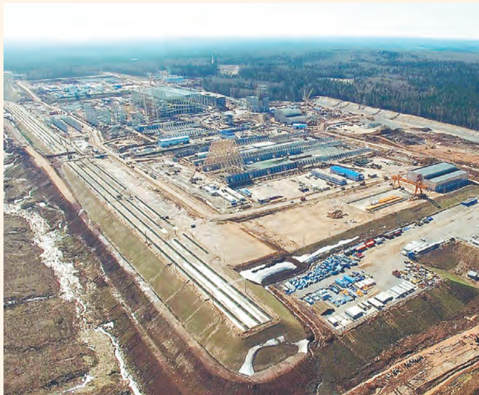
Строительство объектов «ЕвроХима» идёт уверенными темпами
