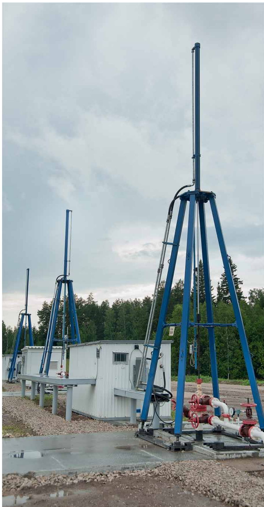
Интеллектуальная кустовая площадка скважин на базе гидроприводов «Гейзер»
